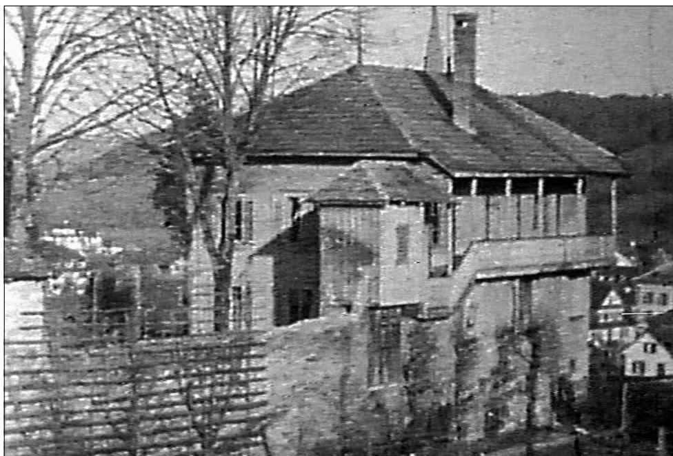
Älteste Foto vom Bergli (mit noch vorhandener Stadtmauer); bot ergänzend zum Schloss weitere Unterrichtsräume.
