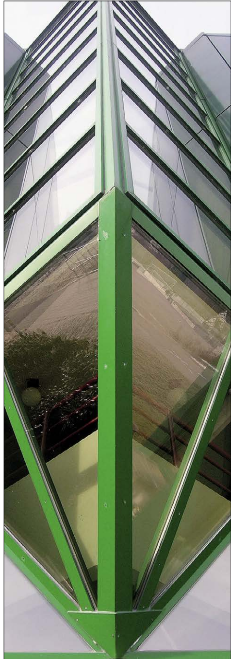
Interessantes Fassadenelement am Berufsschulhaus BBZW-Willisau. Foto: Schularchiv
